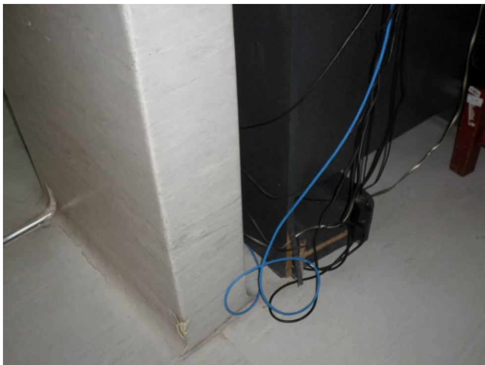
Contrazocalo deteriorado
